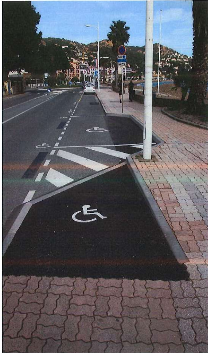
Place de parking boulevard de la plage (RD 559) avec rampe d'accès
