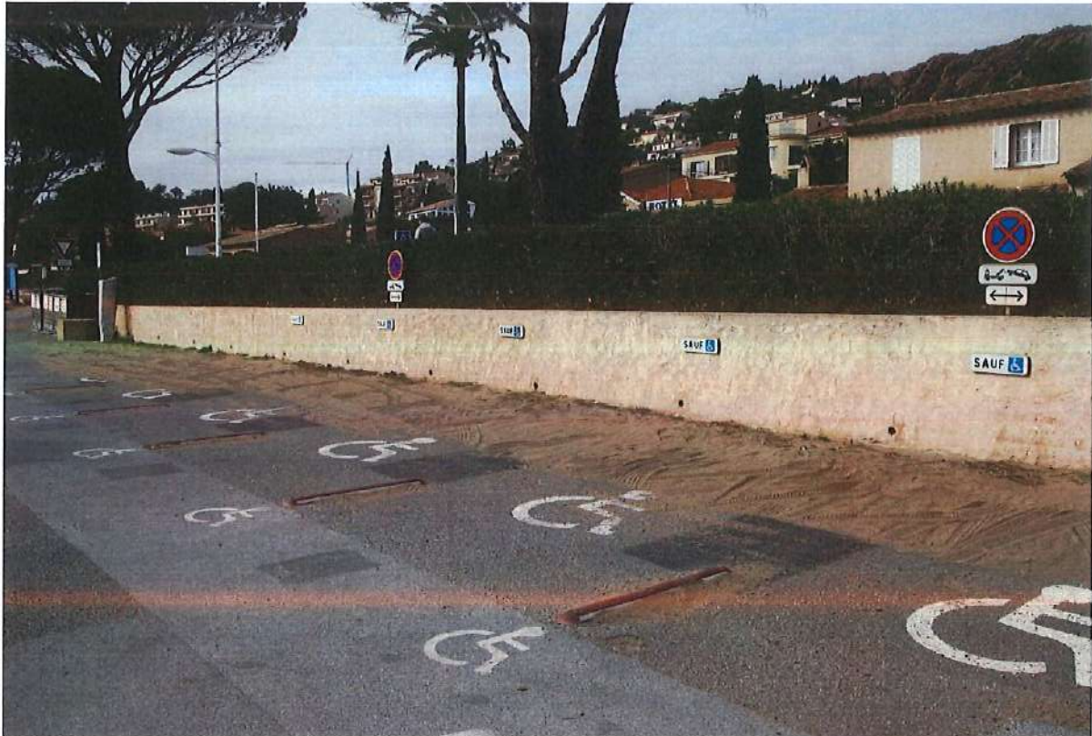
Places de stationnement PMR situés sur le parking de la base nautique / « Handiplage »
