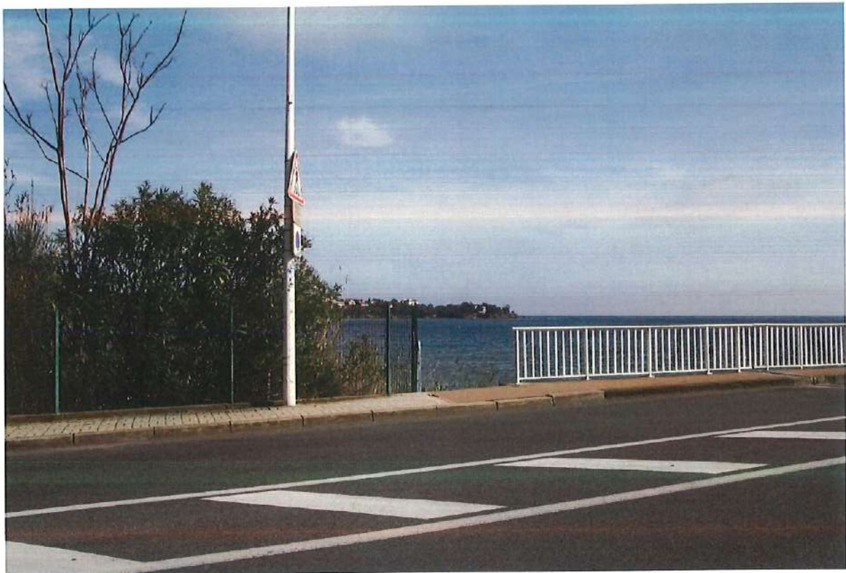
Accès au lot 1 depuis le boulevard de la plage (RD 559)
