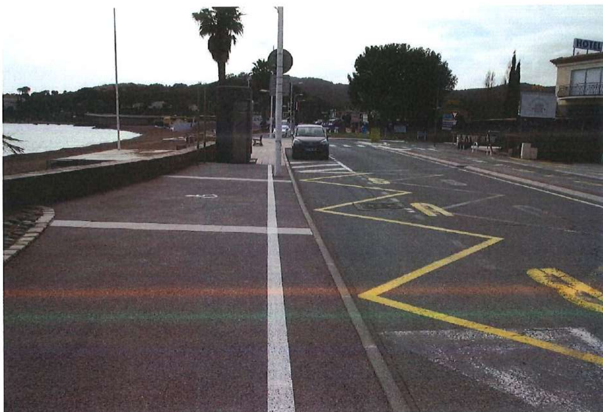
Zone PMR à l'arrêt de bus le long du boulevard de la plage (RD 559)
